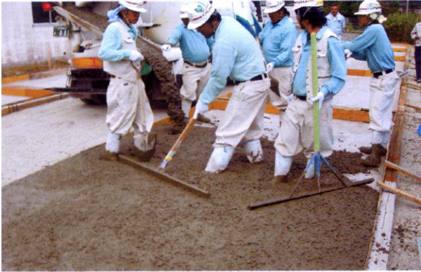
① 打設中、かき棒引き
